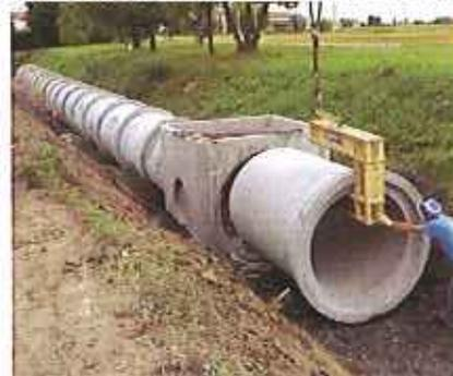
Qualora la posa della linea di raccolta adibita ad invaso diffuso avvenga al di sotto del massimo livello di falda, è necessaria la prova di tenuta idraulica della stessa.
