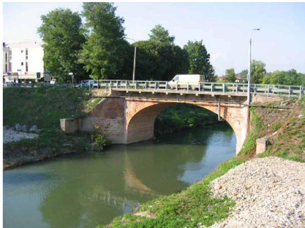
Figura 19 – Rappresentazione del ponte di Ponte Vigodarzere (NB: fotografia presa da monte quindi ribaltata rispetto alla sezione di HecRas riportata a sinistra). La fotografia risale a prima della realizzazione del nuovo ponte affiancato a quello storico del 1859 (successivamente oggetto di interventi di consolidamento e adeguamento strutturale).
